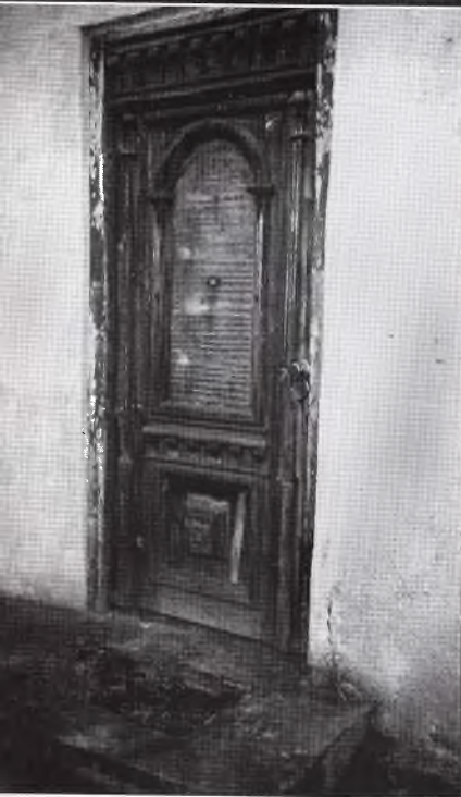
Wasserwerk Haus 3 b außen und innen
