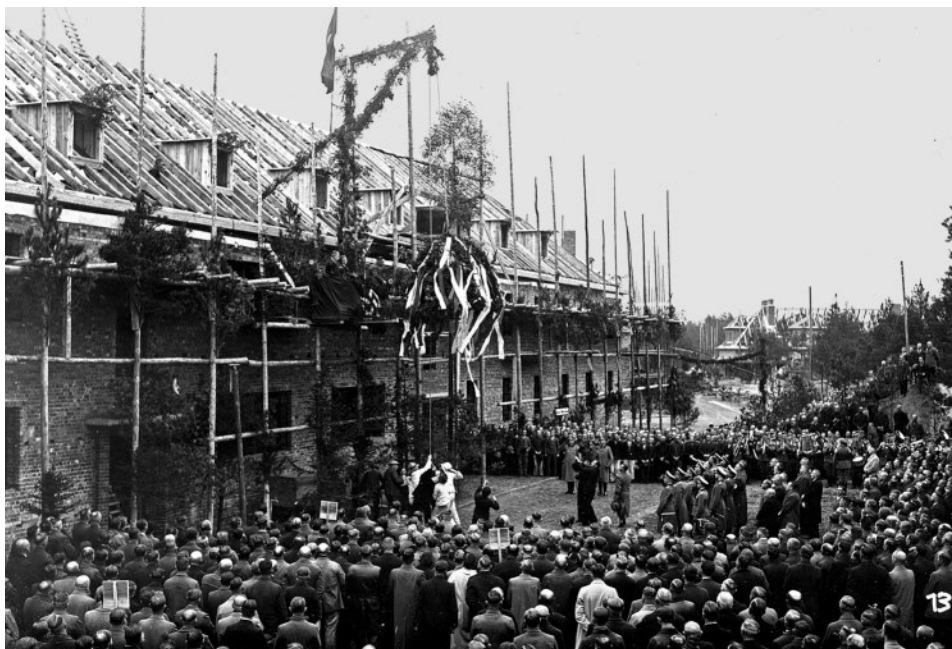
Richtfest 3. Bauabschnitt Winter 1937/38; in der Mitte des Bildes hinter den beiden schwarz gekleideten Arbeitern: links Oberst Thofern, Mitte General v. Blaskowitz, rechts Major Lex
